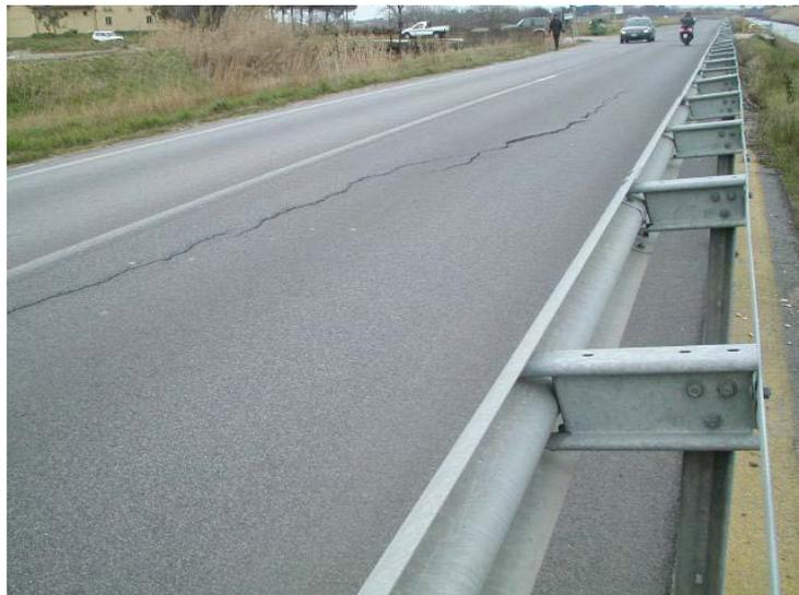
*VIA DELLE IDROVORE DI FIUMICINO - cedimenti struttura stradale*
