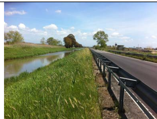
10. Area di Intervento - Area in cui è previsto l'intervento: realizzazione di una paratia in pali di castagno infissi
