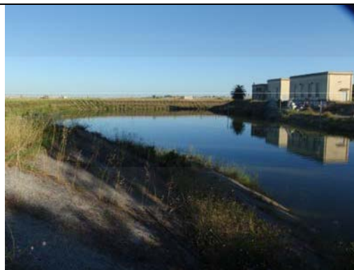
8. Paesaggio della bonifica – Idrovore di Focene
