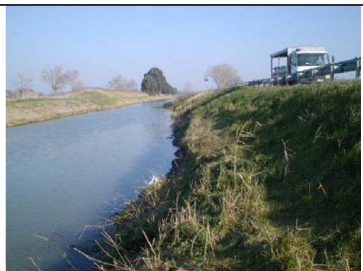
11. Area di Intervento - Area in cui è previsto l'intervento: realizzazione di una paratia in pali di castagno infissi
