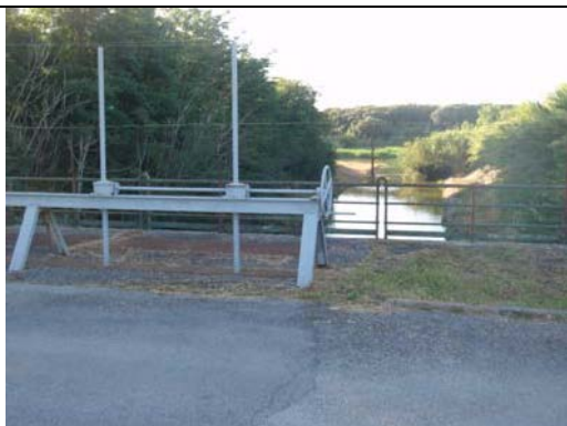
9. Paesaggio della bonifica – Idrovore di Focene
