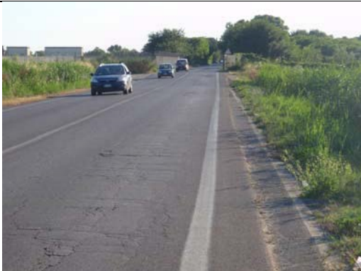
3. Vista dell'area (sulla destra) da via delle Idrovore di Fiumicino
