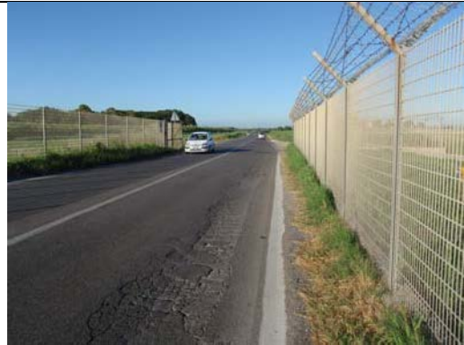
2. Sulla sinistra la recinzione dell'area, sulla destra la recinzione dell'aeroporto di Fiumicino
