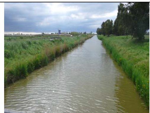
12. Area di Intervento - Area in cui è previsto l'intervento: realizzazione di una paratia in pali di castagno infissi
